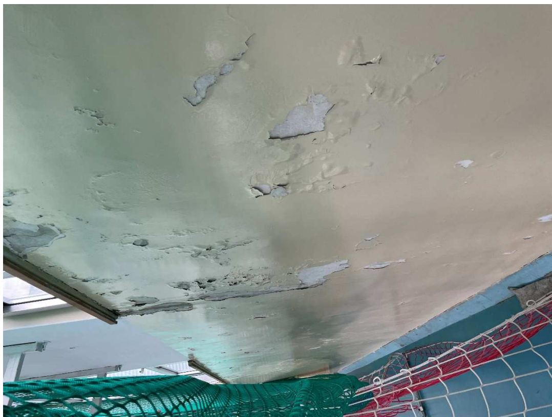
FOT. 14 Wnętrze Sali sportowej, widoczne złuszczenia ścian
