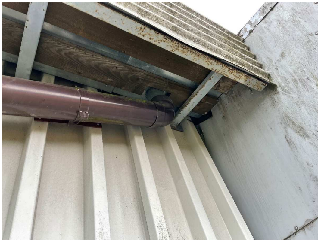
FOT. 7 Istniejące orywnowanie, obróbki
